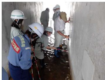
写真:函体内部の変状確認の実習
