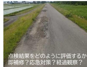
写真:堤防天端の荷重による沈下
