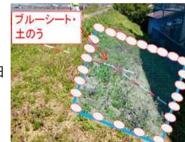
写真:「はらみ出し」の応急対策例
