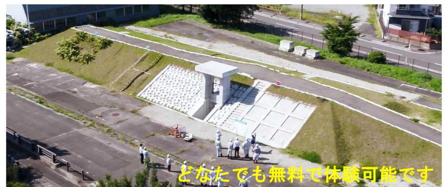
体験型河川堤防等実習施設は、堤防等の異常箇所(変状)が常に確認できるように**不具合を再現した実物大の実習施設**です。
